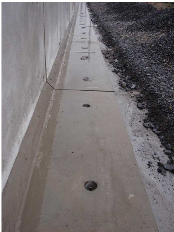
Obrázek 1 - Kotvení základny nástupištěního prefabrikátu H a L
